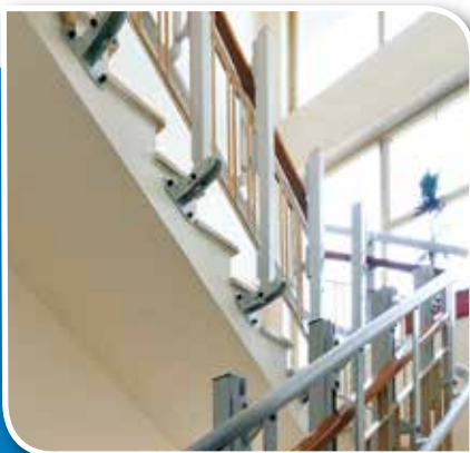
Fissaggio guida allo zoccolo della scala
