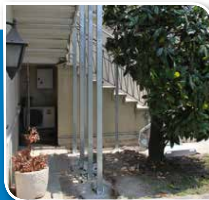
Fissaggio guida con pali lunghi da terra
