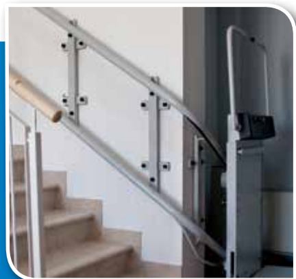
Fissaggio guida a muro
